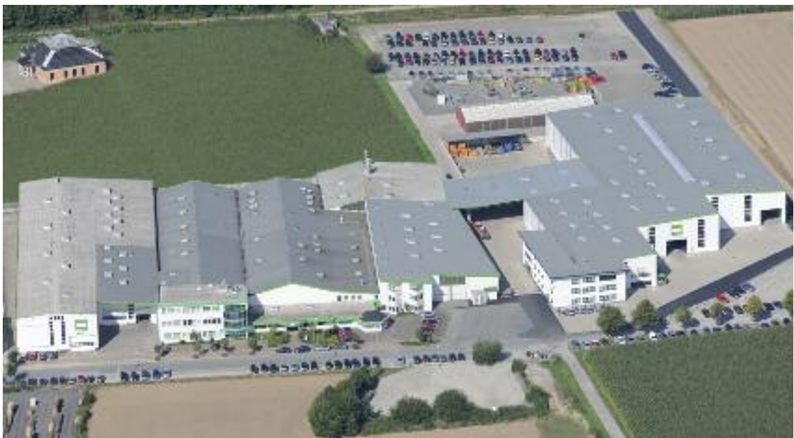
Stammsitz der HEGLA-Gruppe in Beverungen mit den neuen Fertigungshallen (rechts im Bild)
